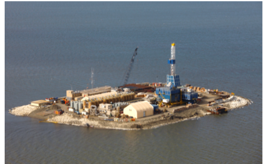
Ooguruk Island Drill Site (ODS)
