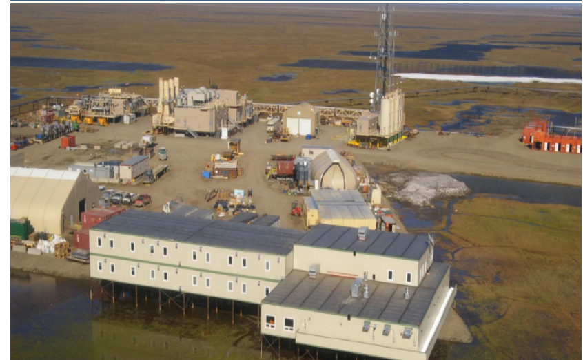
Ooguruk Tie-In Pad (OTP)
